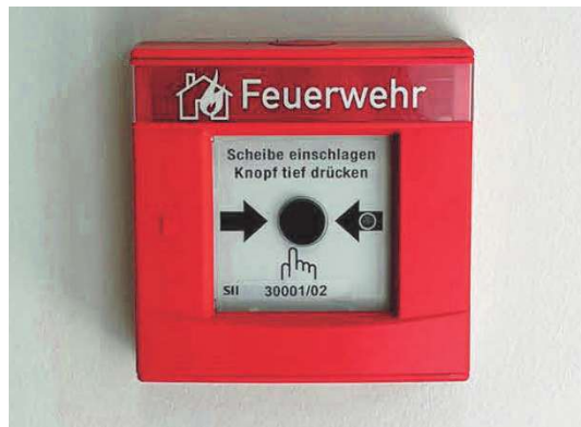
Abb. 13: Handfeuermelder Brandmeldeanlage
