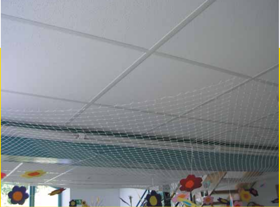
Schallabsorbierende Decke mit abgehängten Akustikplatten
