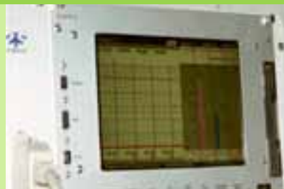
Gaswarneinrichtung (optisch und akustischer Alarm, Monitor mit Messwerten)
