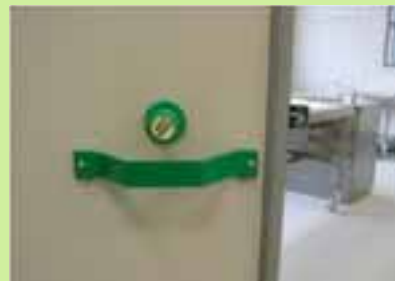
Kühlzelle mit Notentriegelung
