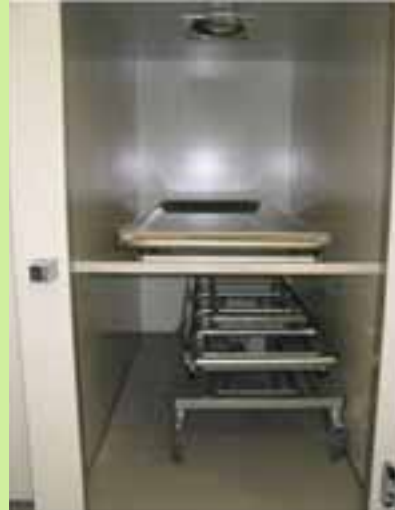
Kühlzelle mit Notentriegelung
