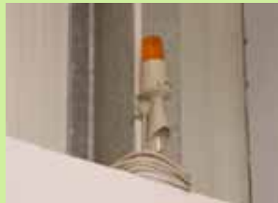
Gaswarneinrichtung (optisch und akustischer Alarm, Monitor mit Messwerten)
